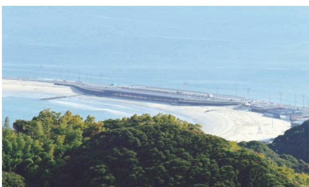
解体が進む志賀島橋(潮見公園より)
